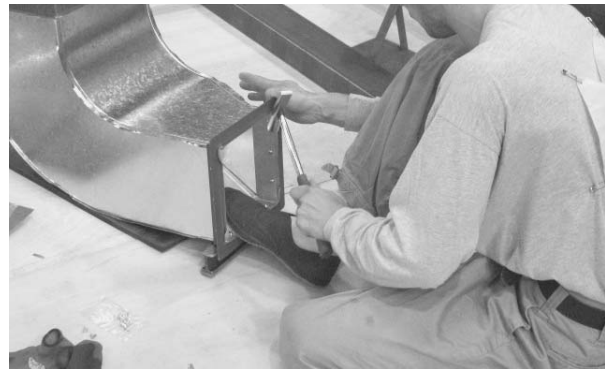
リベットをかきめています
