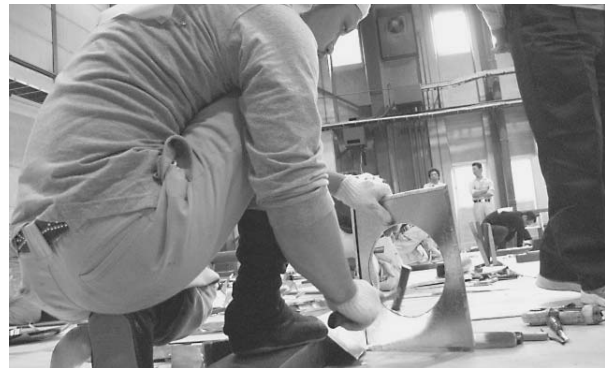
円筒を取り付ける部分の加工中
